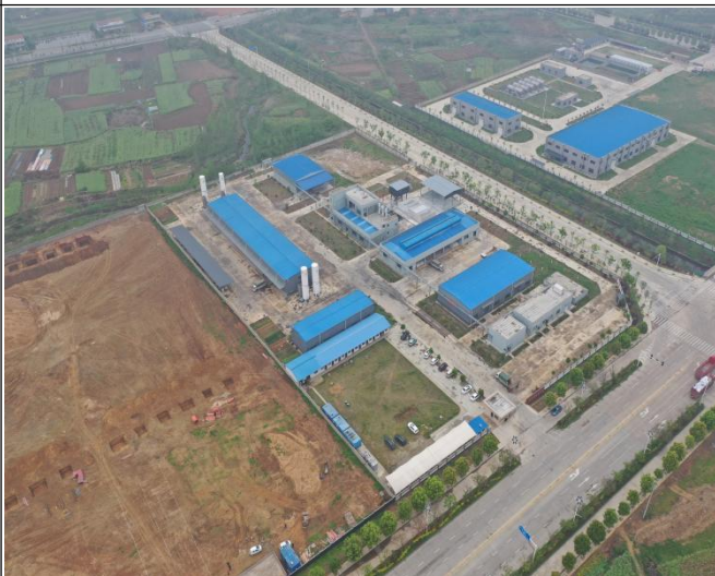
项目东南侧湖北安瑞泰气体有限公司现状（拍摄时间2023年4月）
