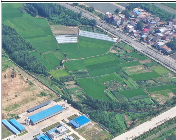
项目东北侧现状（拍摄时间2023年7月）
